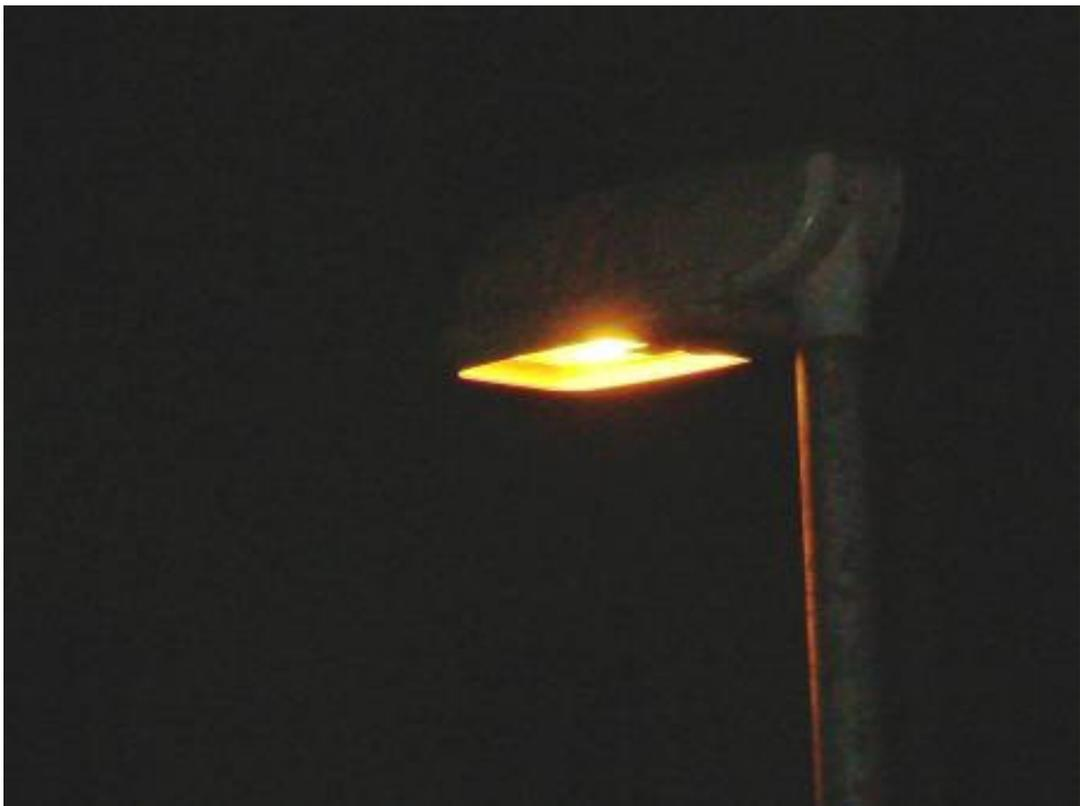
Hier ist die planparallele Streuscheibe und die waagerechte Anordnung des Lampenschirmes bei Tageslicht und im nächtlichen Betrieb gut zu erkennen.
